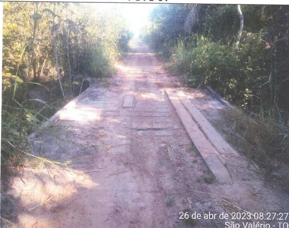
PONTE SOBRE O CORREGO BOI RABICHO MUNICÍPIO DE SÃO VALÉRIO – TO
