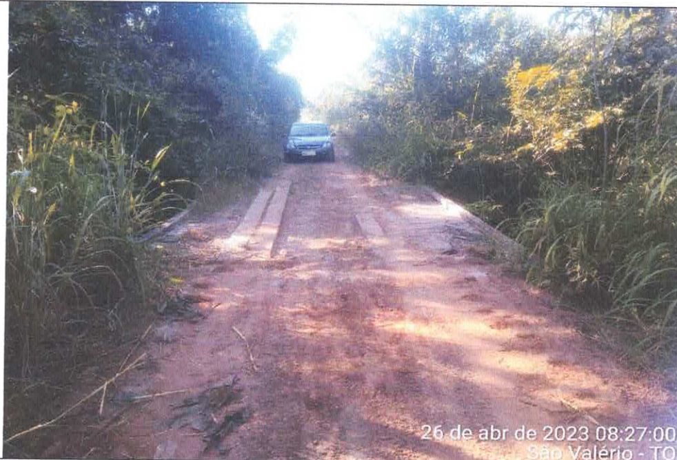
PONTE SOBRE O CORREGO BOI RABICHO MUNICÍPIO DE SÃO VALÉRIO – TO
