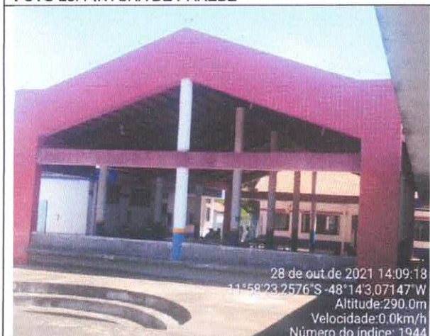
FOTO 27: PINTURA DE PAREDE
