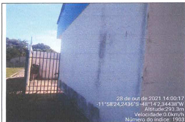
FOTO 25: PINTURA DE PAREDE
