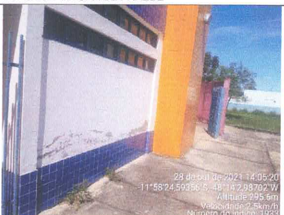
FOTO 30: PINTURA DE PAREDE
