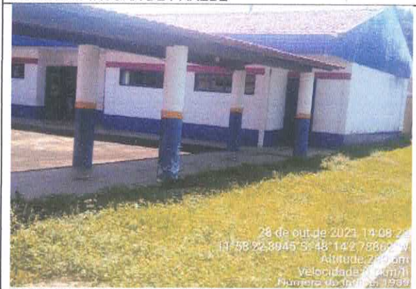
FOTO 29: PINTURA DE PAREDE
