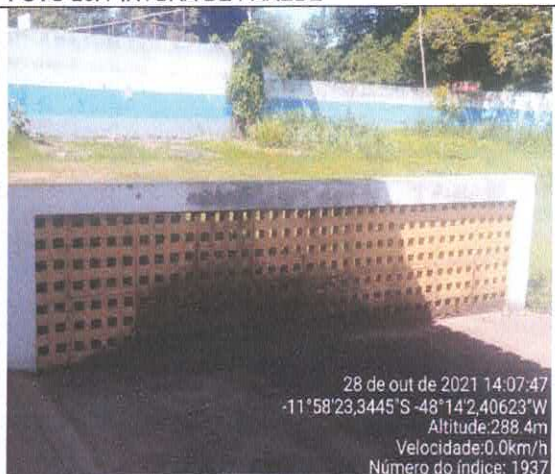
FOTO 28: PINTURA DE PAREDE
