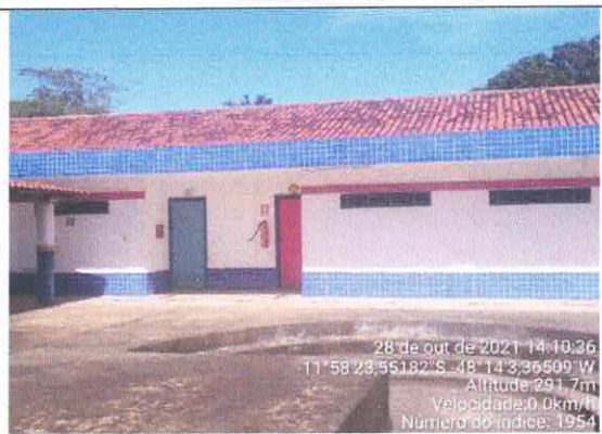
FOTO 26: PINTURA DE PAREDE
