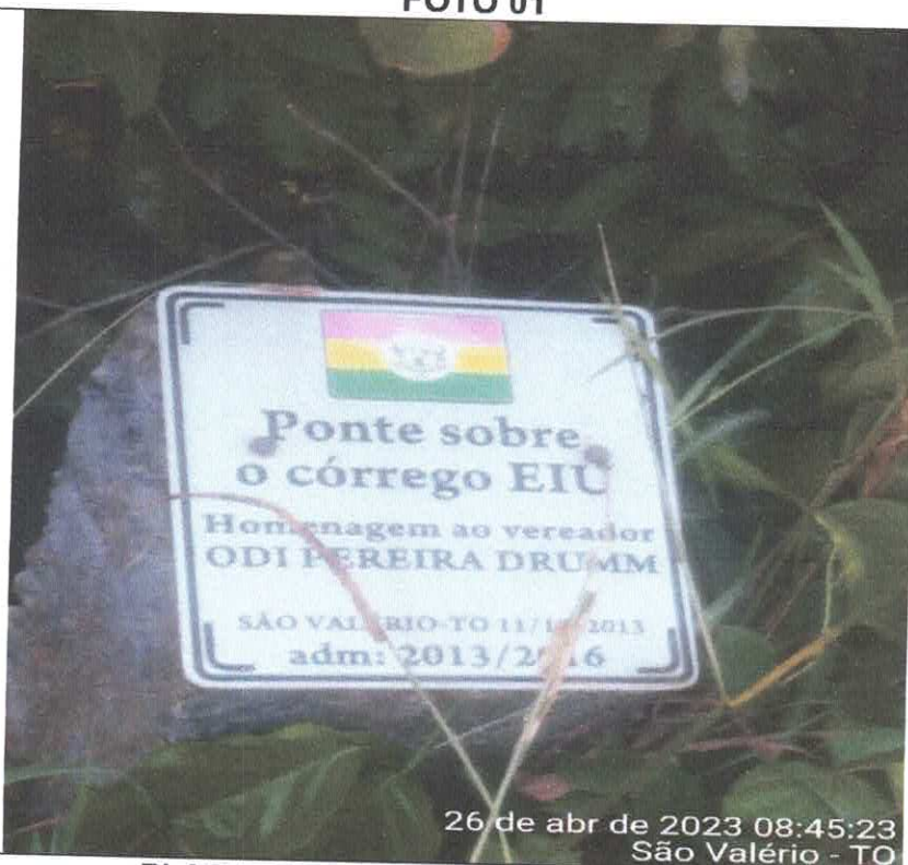
PLACA PONTE SOBRE O CORREGO EIU
