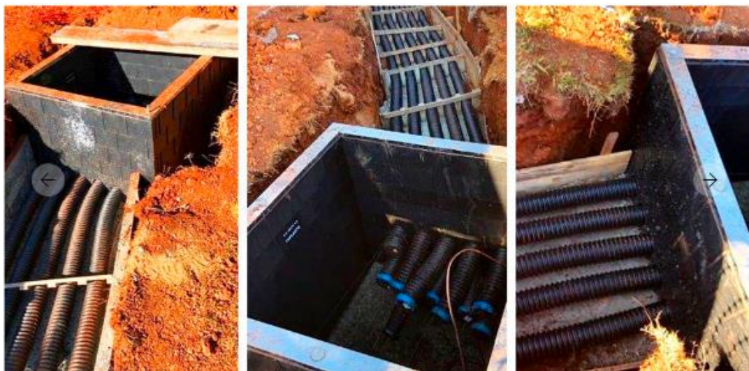
Instalação de caixa de passagem
